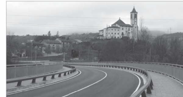
Al pont de la Gleva, entre Manlleu i les Masies de Voltregà, s'hi va haver de fer una actuació d'urgència perquè un accident de trànsit va desplaçar el tauler. Finalment, es va canviar aquesta peça per garantir la màxima seguretat i es va aprofitar per fer voreres protegides per a vianants. DIPUTACIÓ DE BARCELONA
