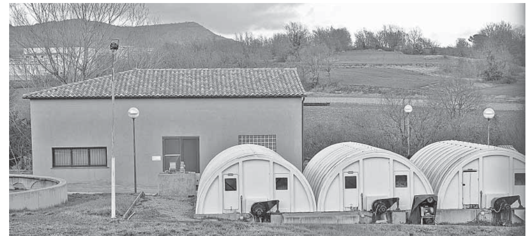
Un detall de la depuradora de Moià (fot. C.I.C. - Moià)
