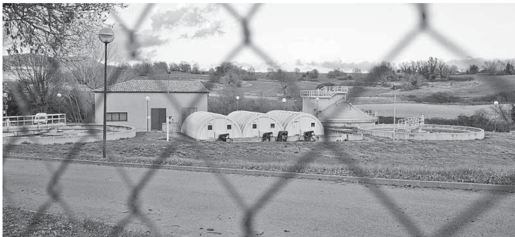
La depuradora de Moià, des de l'exterior del recinte (fot. C.I.C. - Moià)
