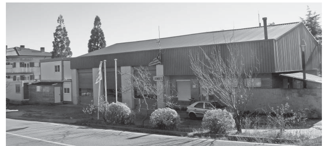
Aspecte actual del parc de bombers (fot. J. Riera)
