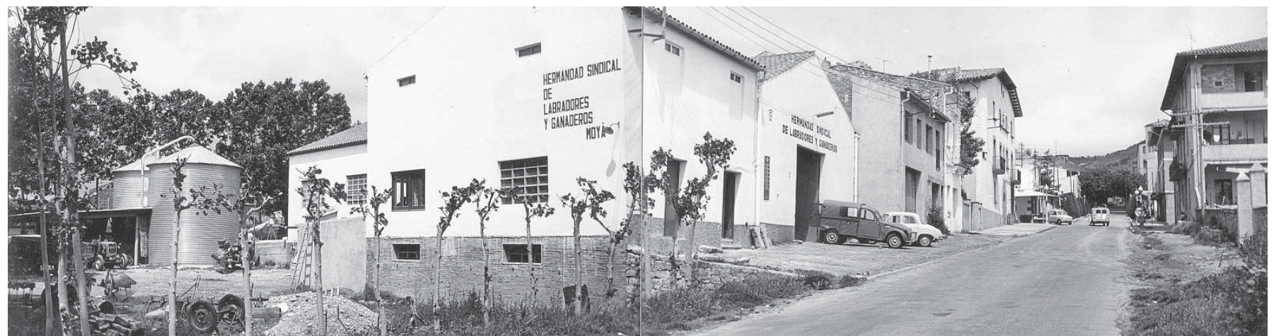
Conjunt de les instal·lacions del Sindicat, en la dècada de 1950
