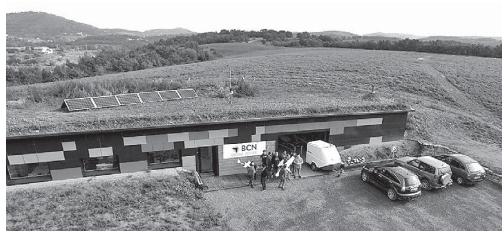
Instal·lacions del centre (fot. BCN Drone Center)
