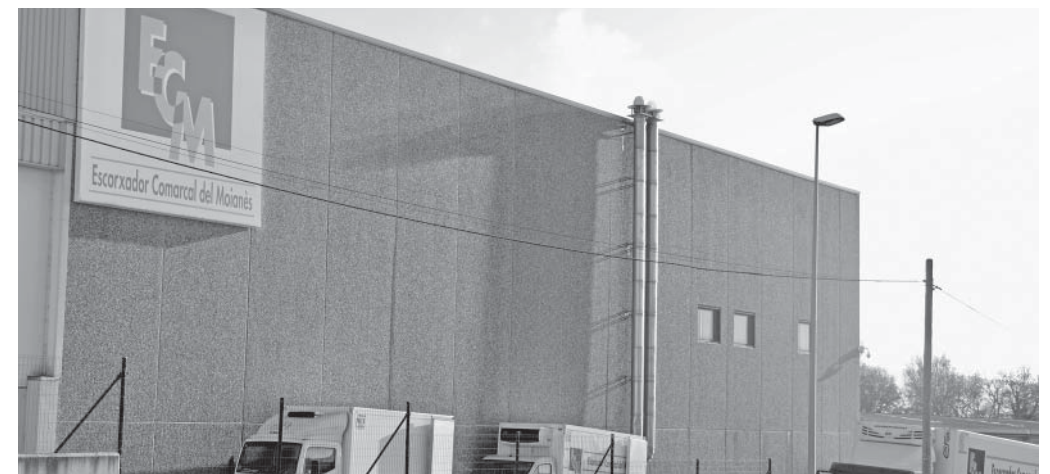
Escorxadador Comarcal del Moianès (fot. J. Font)
