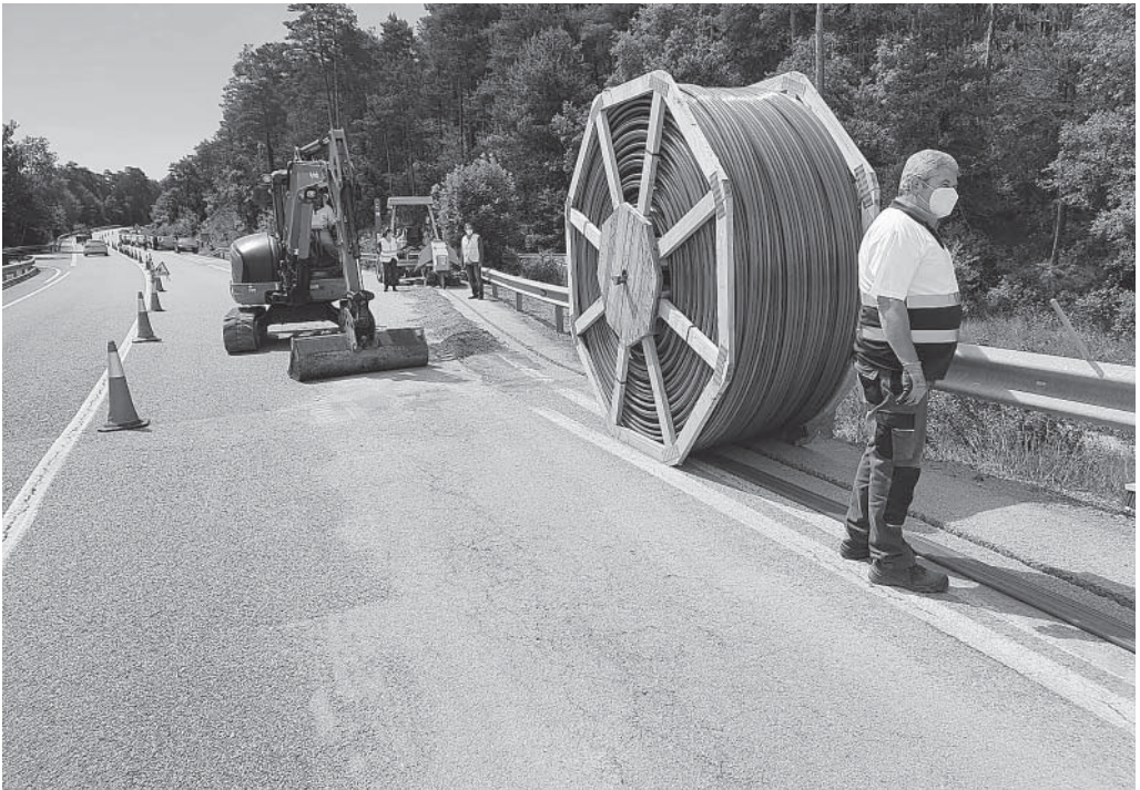
Acció reivindicativa de Capgirem Moià – CUP. Obres de desplegament de la fibra òptica
