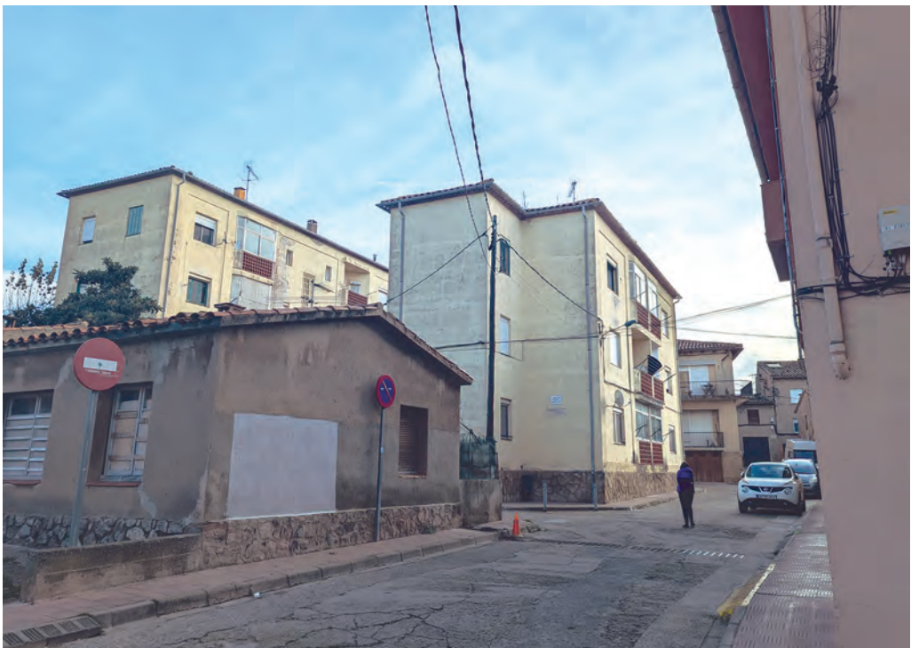
Blocs de pisos propietat de l'ajuntament al carrer Martí i Pol, en procés de rehabilitació (fot. E. Altarriba)
