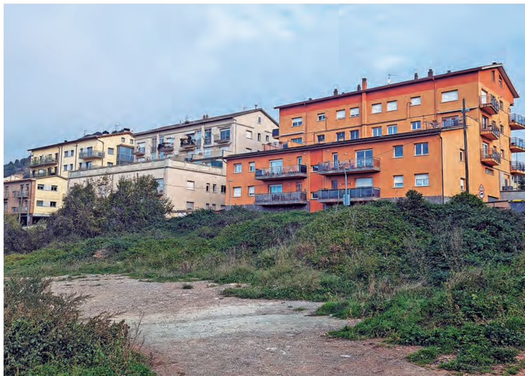
Solar buit i edificis a la zona de la carretera de Manresa (fot. E. Altarriba)
