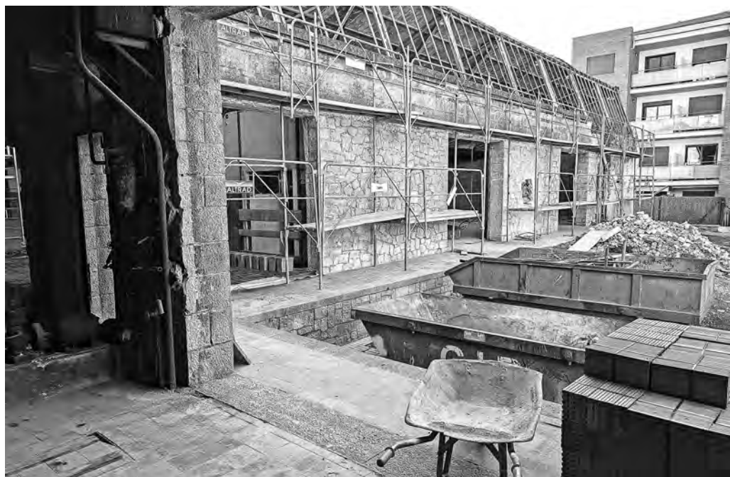
Façana de Cal Comadran a enderrocar (fot. E. Altarriba)
