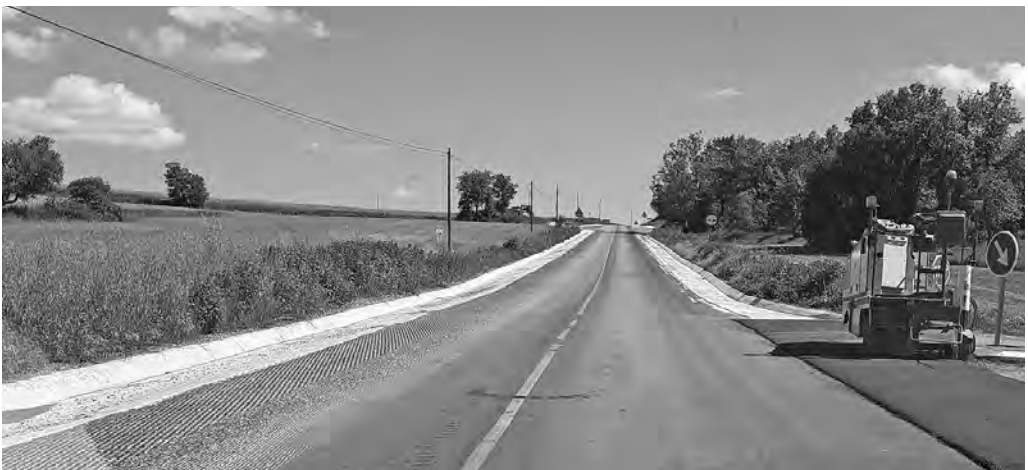
La carretera C-59, prop de Moià (fot. Consell Comarcal)
