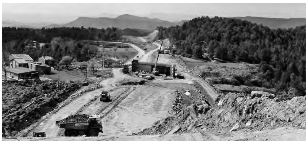
Obres de construcció de l'Eix Transversal, a Santa Maria d'Oló (fot. Josep Canamasas)
